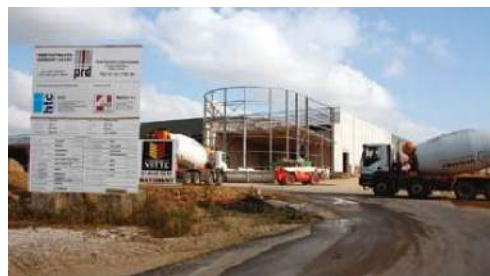
PRD réalise pour AXA un bâtiment de 38 000 m 2 dans le parc d'activité Jean-Monnet, à Vert-Saint-Denis.
